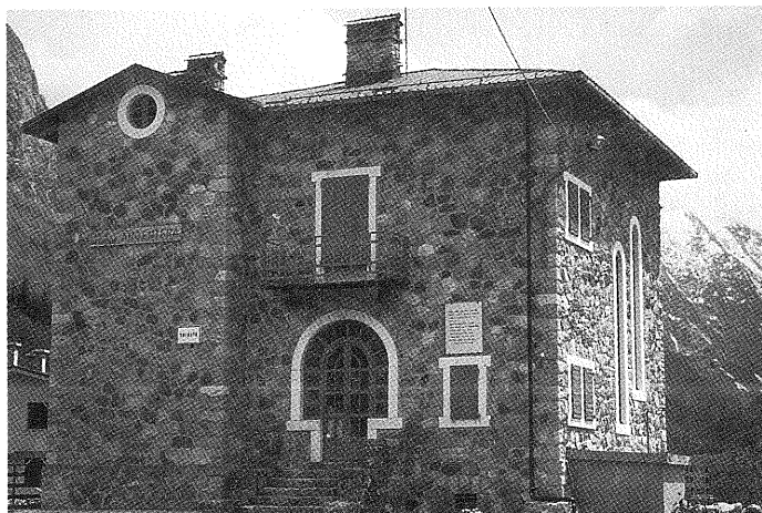
Ostello del parco - Trinità Entracque
